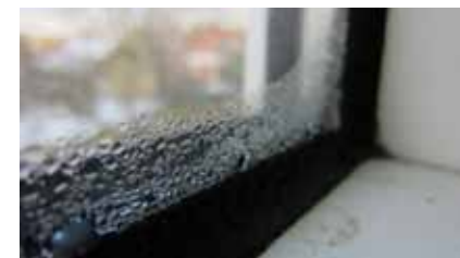
Billede af vindue fra Frydenspark med kondens. Kondensen opstår fordi fugtigheden boligen er for høj, som igen skyldes den dårlige ventilation og dårligt isolerende vinduer.
