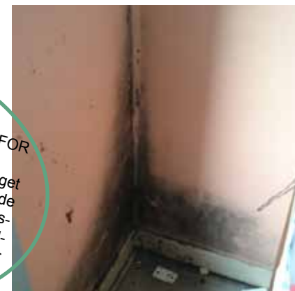
Her er et eksempel fra Frydenspark hvor der er opstået skimmelsvamp, som er dårligt for lungerne. Årsagen er ringe ventilation og dermed høj fugtighed i boligen
