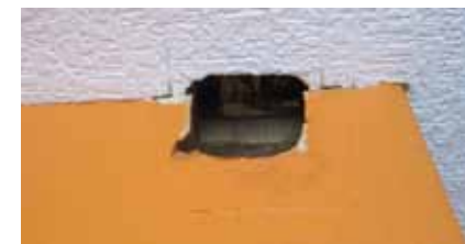
Billedet viser en aftrækskanal fra køkkenet. Flere af disse kanaler er lukket med aviser af beboere fordi det giver kulde-gener. Dette medfører et dårligt indeklima som er usundt og sygdomsfremkaldende.
